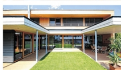
Die Familie Gruber am großen Esstisch: den Schlafkammern im ersten Stock ist ein Balkon vorgelagert; die teilüberdachte Terrasse im Erdgeschoss; zwei Flanken umschließen den Grünbereich (links von oben).
